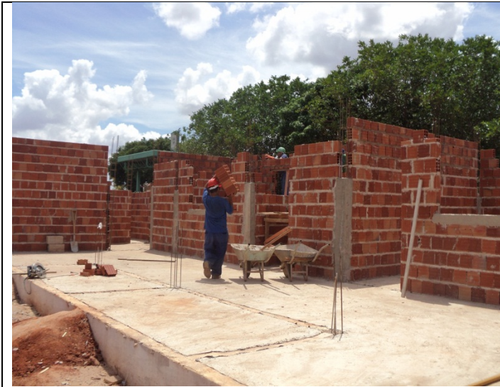
Figura 3: Obras da sede administrativa.
