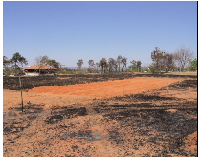
Figura 4: Obra da quadra de volei de areia.
