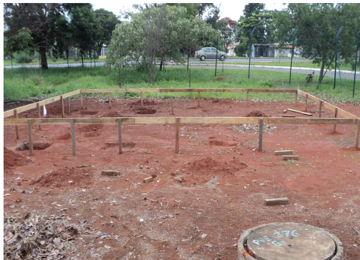
Figura 5: Início da obra da Guarita.
